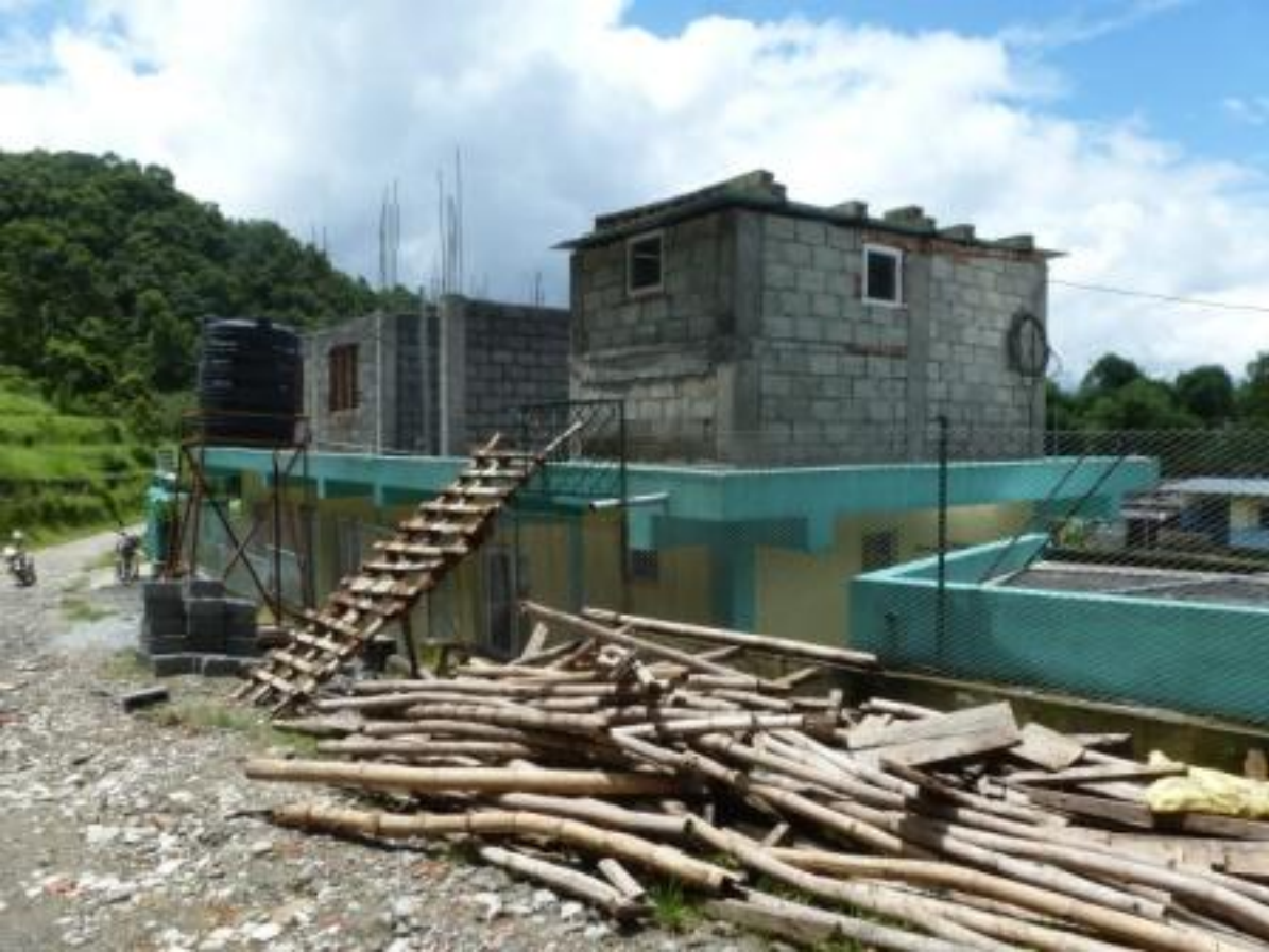
Die Arbeiten am Hostel werden fortgesetzt
